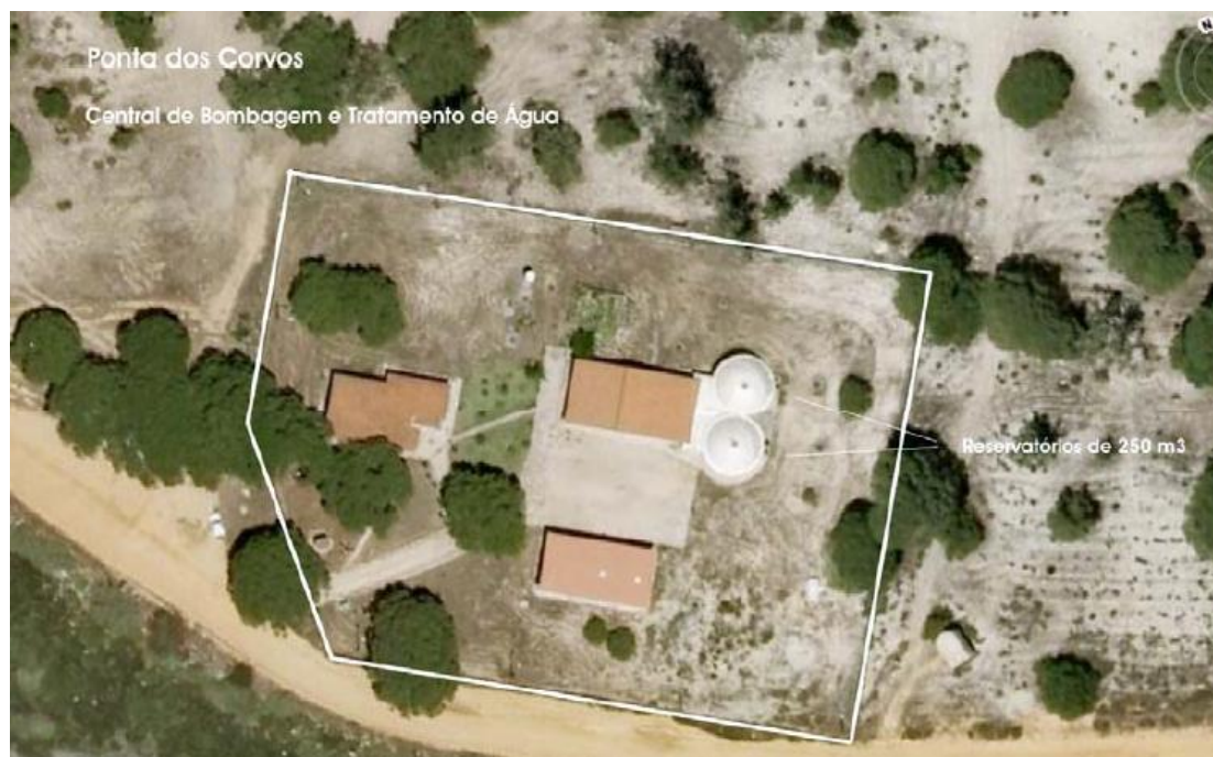
Figura 67: Estação de tratamento de águas da BNL
