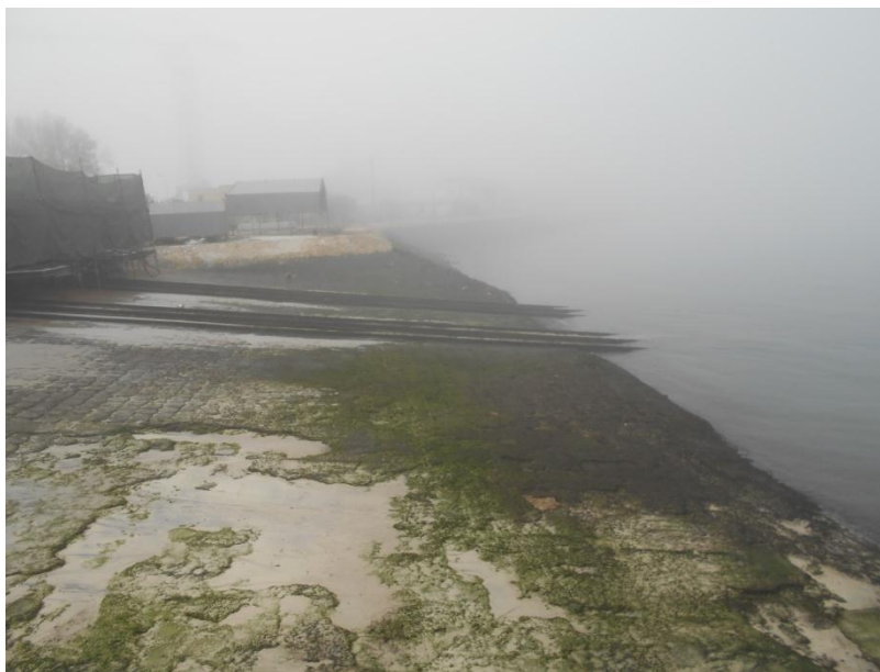
Figura 134: Perspetiva da marginal (desde o edifício 58 até 44)
