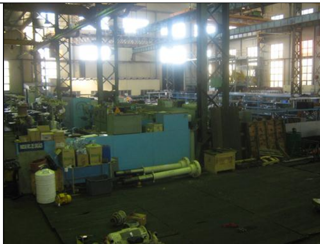
Figura 26: Caldeiraria de tubos
