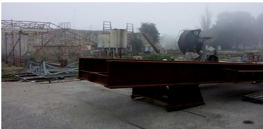
Figura 90: Situação comum na zona de intervenção
