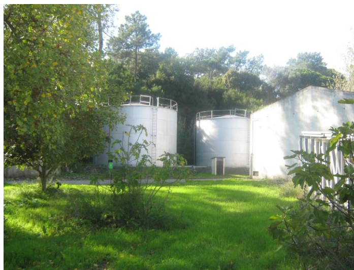
Figura 70: Depósitos de água
