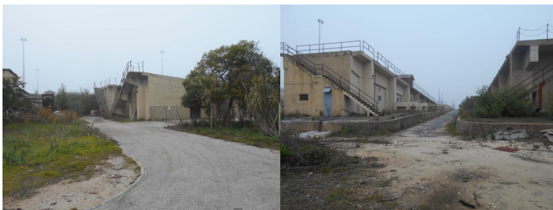
Figura 130: Perspetiva do edifício 66 e 67 (foto 15) e do edifício 65 (foto 16)
